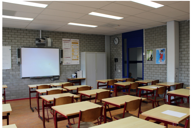
Klaslokaal met aan- en afvoerroosters luchtbehandeling opgenomen in verlaagd plafond
